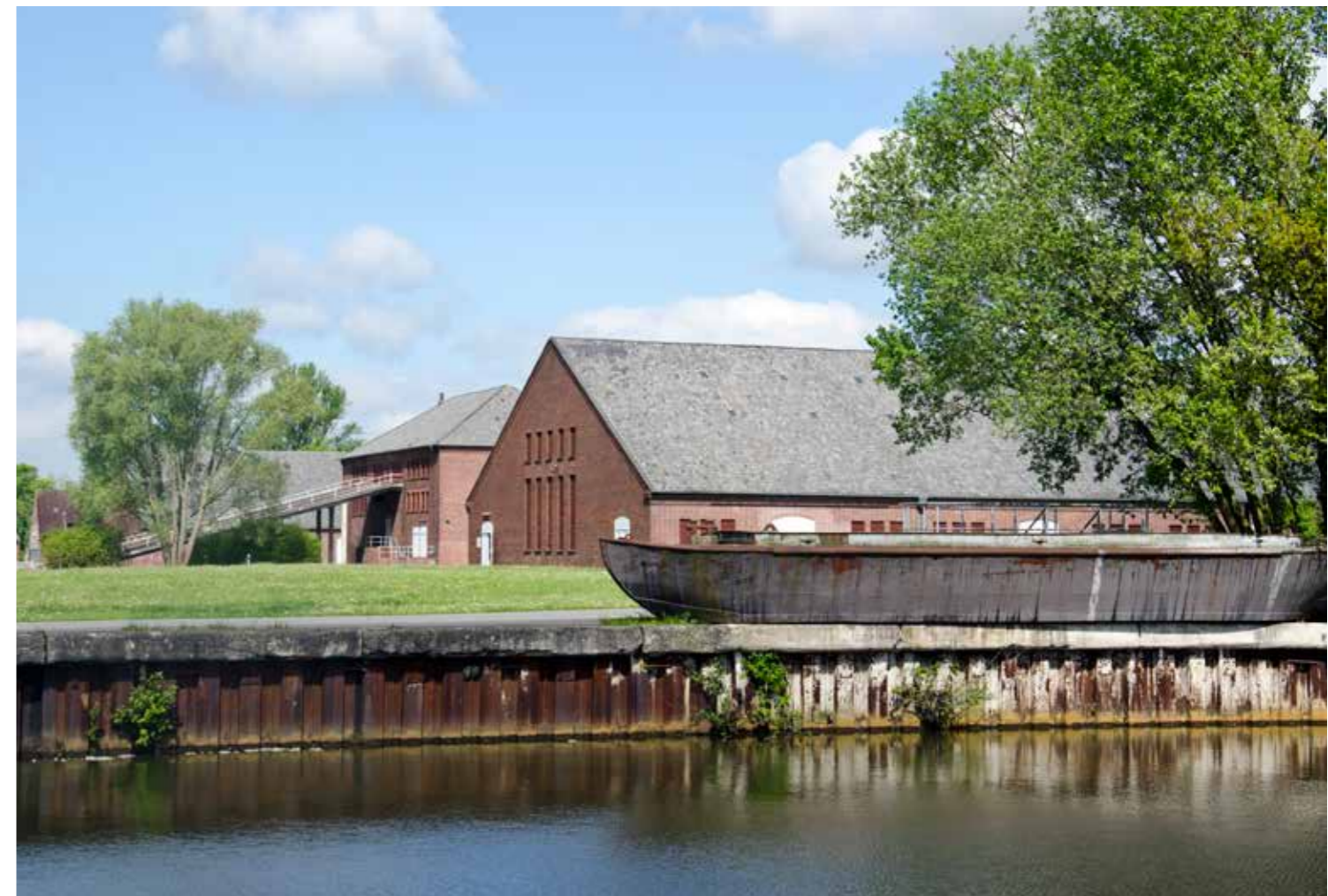
Hafenbecken und Schute am ehemaligen Klinkerwerk
