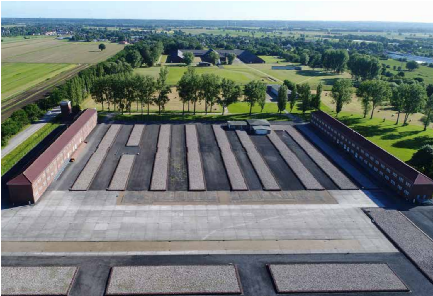
Der Bereich des ehemaligen Häftlingslagers, im Hintergrund das ehemalige Klinkerwerk
