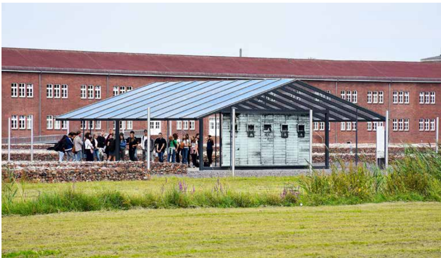
Installation am ehemaligen Standort des „Arrestbunkers“ (Lagergefängnis), im Hintergrund das Studienzentrum der Gedenkstätte
